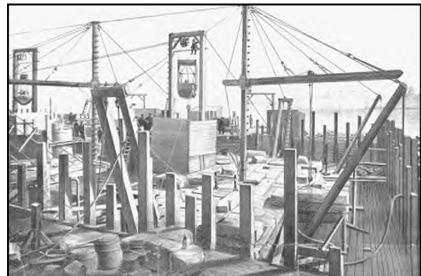
Atop the NY Caisson
