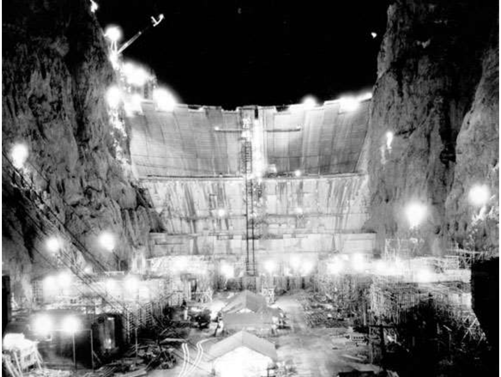
Night construction (June 1934)
